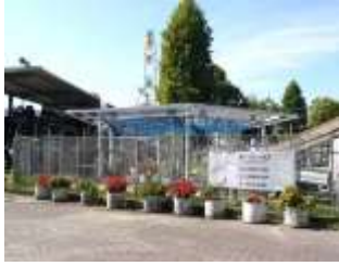
③骨組みが完成
